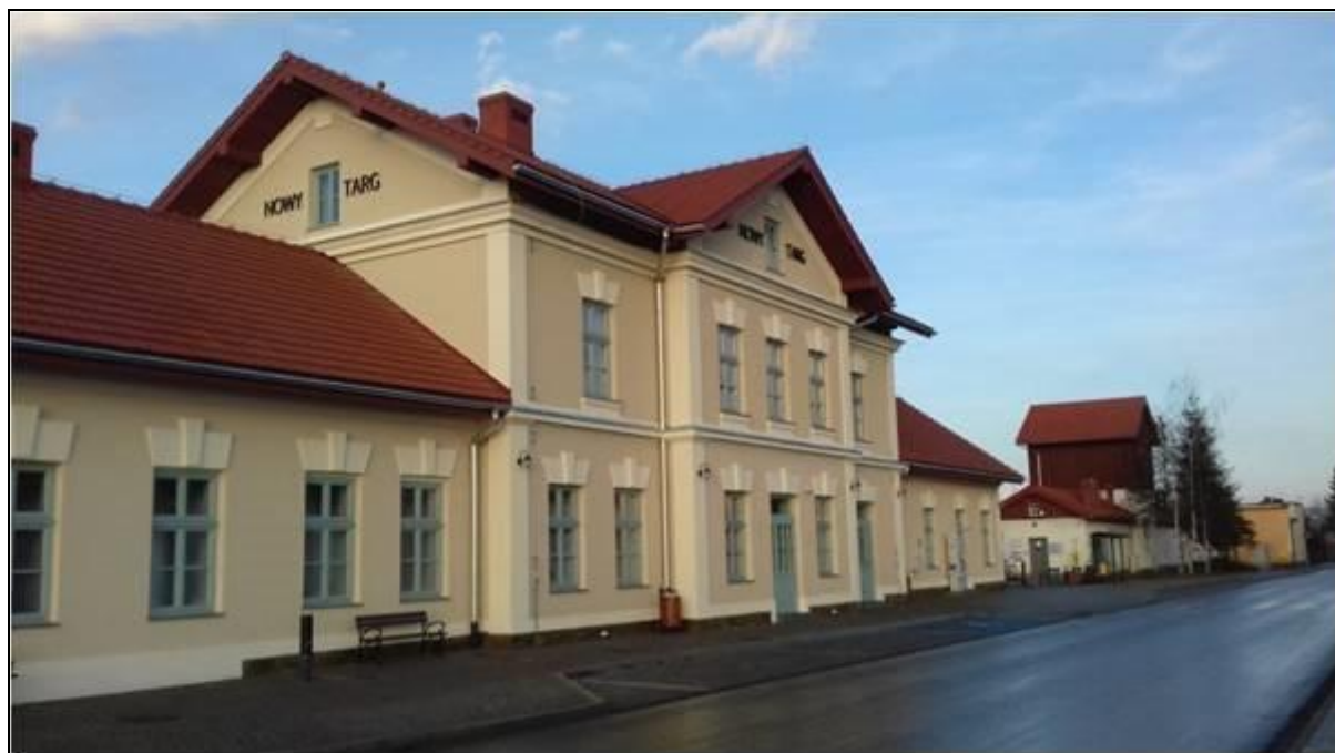
Przebudowany Dworzec PKP wraz z drogą dojazdową
