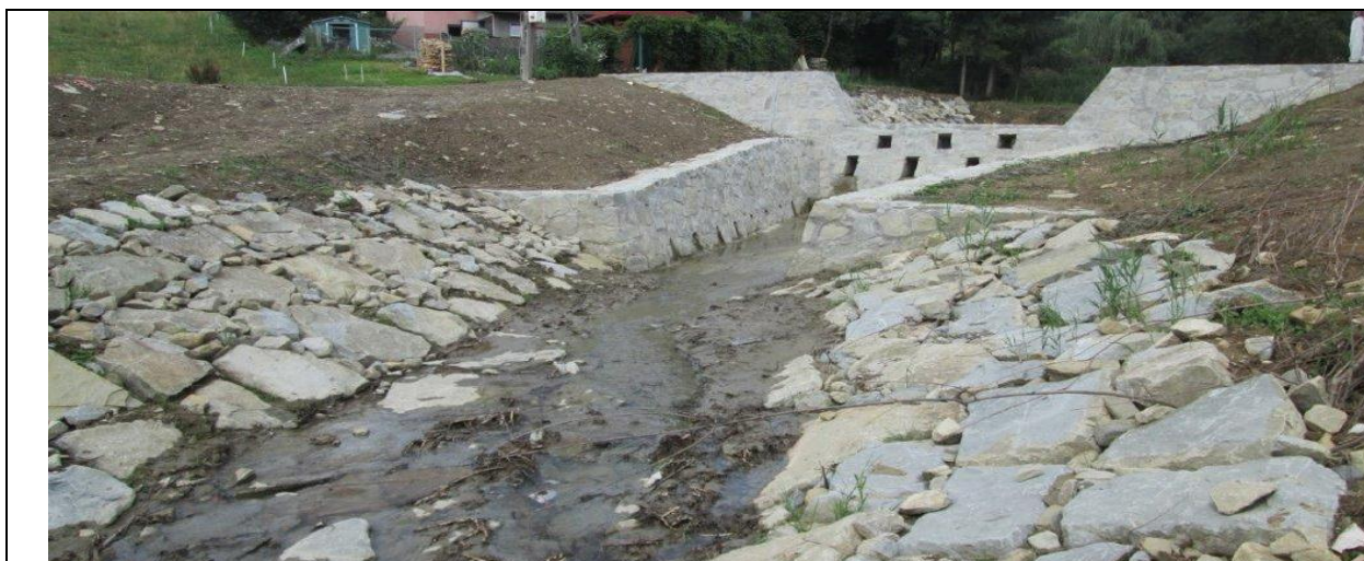
Modernizacja systemów odwodnieniowych - potok Skotnica
