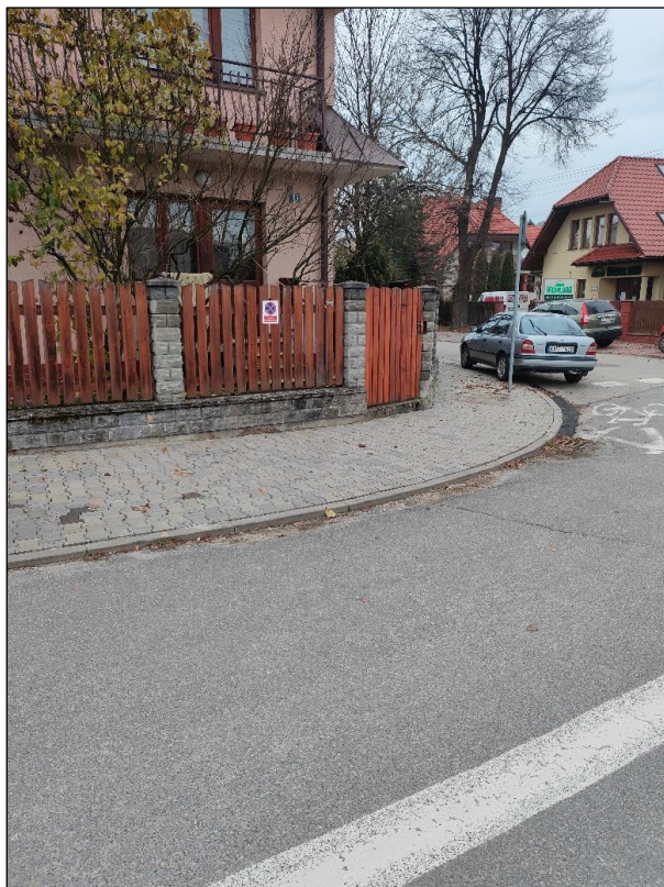
Ciąg pieszy na ul. Bulwarowej po wykonaniu remontu
