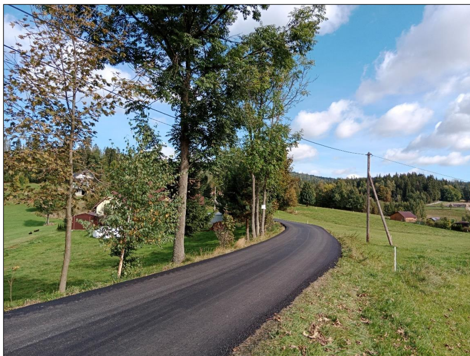
Droga gminna na os. Buflak po wykonaniu remontu
