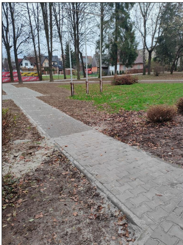
Ciągi piesze na ul. Kopernika po wykonaniu remontu
