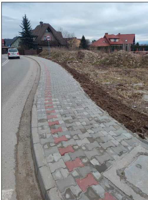
Ciąg pieszy na ul. Grel po wykonaniu remontu
