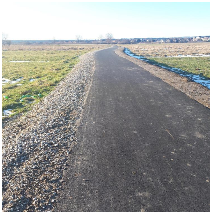
Ścieżka rowerowa na os. Bohaterów Tobruku - po przebudowie
