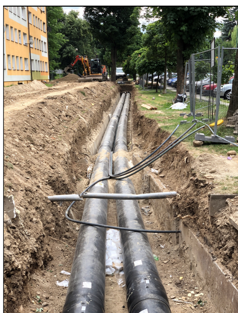
Rozbudowa sieci ciepłowniczej
