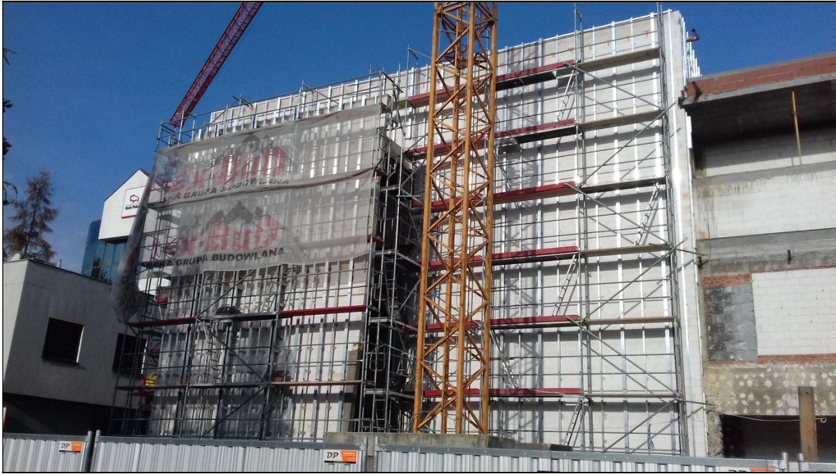
Miejski Ośrodek Kultury – prace modernizacyjne budynku
