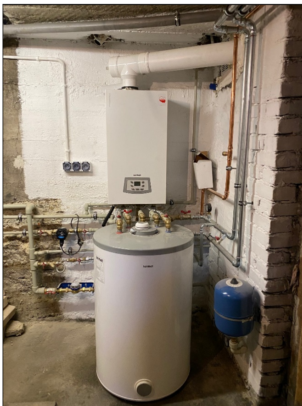
Modernizacja kotłowni na kocioł gazowy
